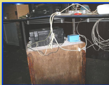
FIGURE 2: Pilier avec le sismomètre (bleu) et l'accéléromètre (boîte noire) à la station de La Chartreuse (LCH) à Liège.
